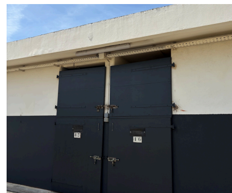
Travaux de réfection de la peinture dans les boxes de la Cité des Marseillais
