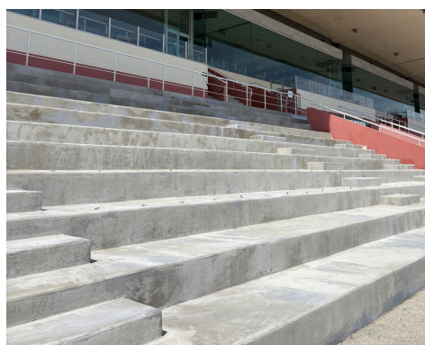
Ponçage et application d'enduit sur le sol des tribunes
