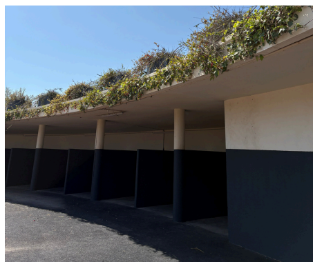
Travaux de réfection de la peinture dans les stalles du Rond de Présentation
