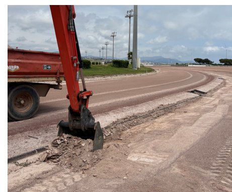
Nettoyage de la voie de dégagement de la piste de course de Trot
