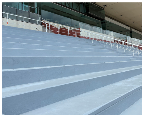
Travaux de réfection de la peinture des 2 premières tribunes
