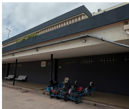
Travaux de réfection de la peinture au niveau de l'espace "animations"
